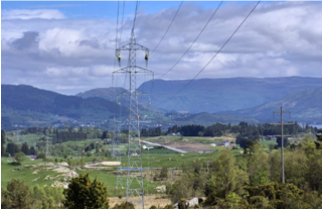
Den nye kraftlinjen fra Ølen via Våg til Bratthammar i Vindafjord og Tysvær kommune vil styrke forsyningssikkerheten på Haugalandet og øke overføringskapasiteten for ny kraftproduksjon i Etne. Foto: Kraftmontasje
