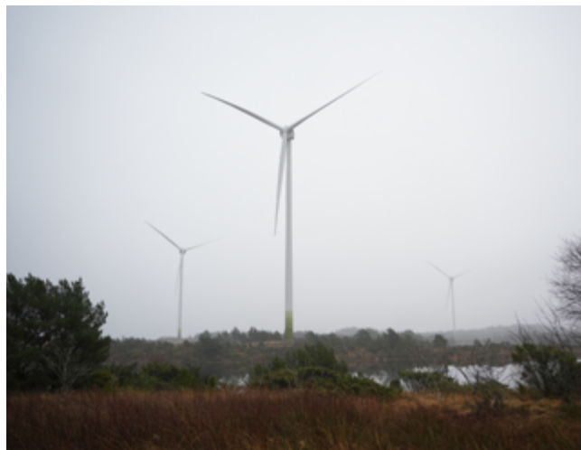
Sunnhordland kraftlag kjøpte Gismarvik vindkraftverk i Tysvær kommune i 2025. Foto: Sunnhordland kraftlag
