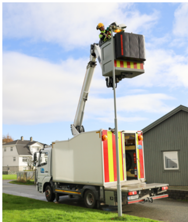
Haugaland Kraft Energi utførte omfattende vedlikehold og modernisering av gatelys i 2025 – fra feilretting og LED-oppgraderinger til nye anlegg. Foto: Haugaland Kraft
