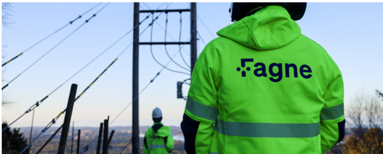
Øysamfunnet på Fitjar har over flere år vært preget av et svakt nett. Sensommeren 2024 startet derfor et omfattende oppgraderingsarbeid. I 2025 ble deler av det nye nettet satt i drift. Foto: Fagne
