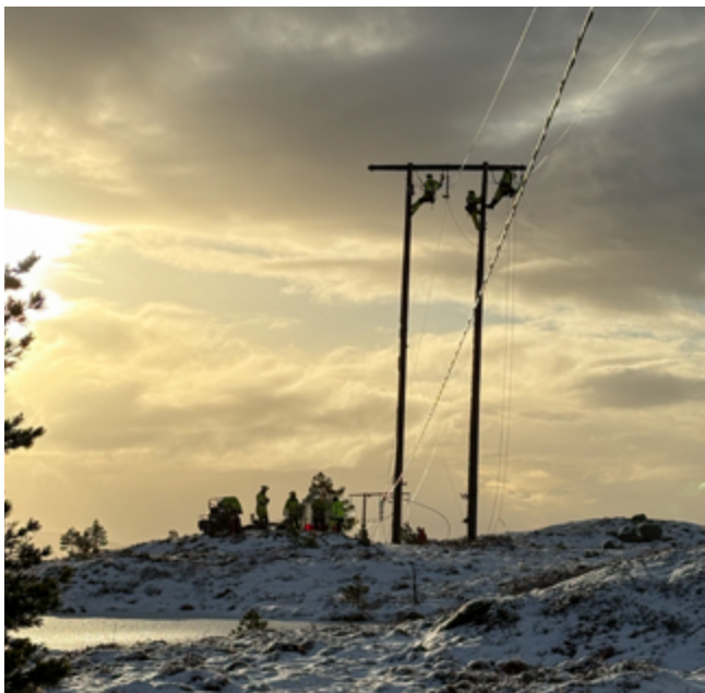
Rask feilretting i fibernettet styrker beredskap og sikrer høy oppetid. Foto: Haugaland Kraft
