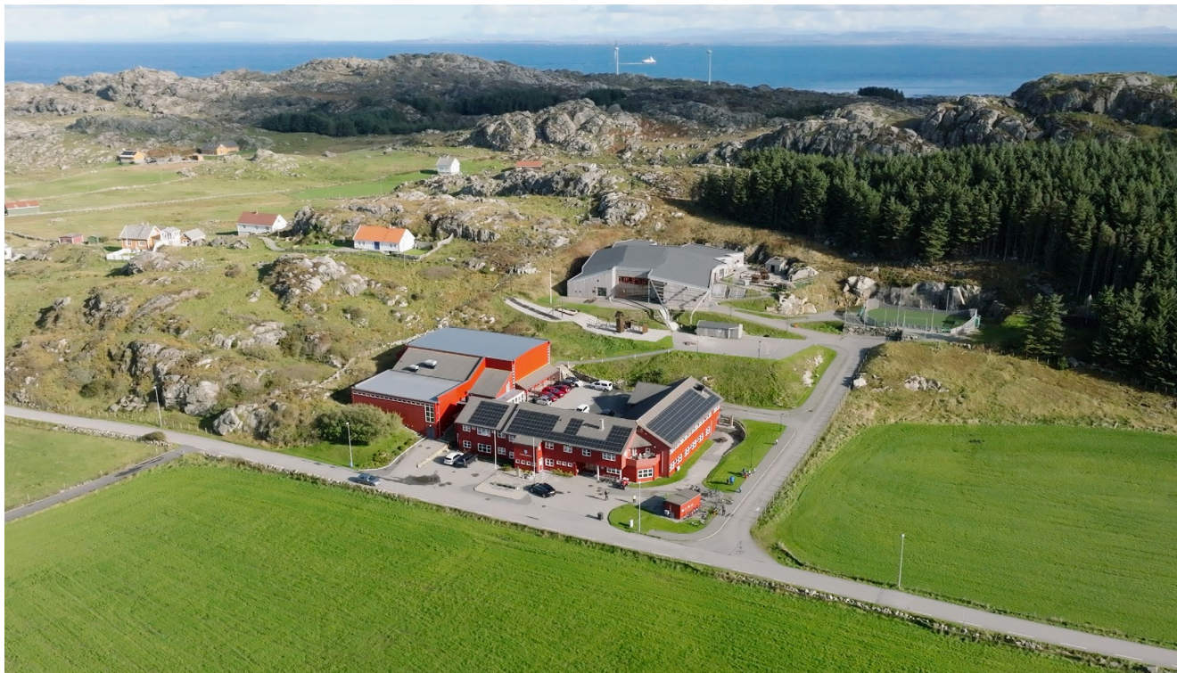
Øysamfunnet Utsira er et levende laboratorium for framtidens energiløsninger, og Haugaland Kraft Energi har i 2023 utstyrt blant annet kommunehuset Siratun med solcellepaneler. Prosjektet er et skritt videre i satsingen på å gjøre kommunen selvforsynt med fornybar energi. Strømmen fra solcellene skal blant annet varme opp svømmebassenget og skolen. Foto: Simon Lesley Olsen, Vestbris
