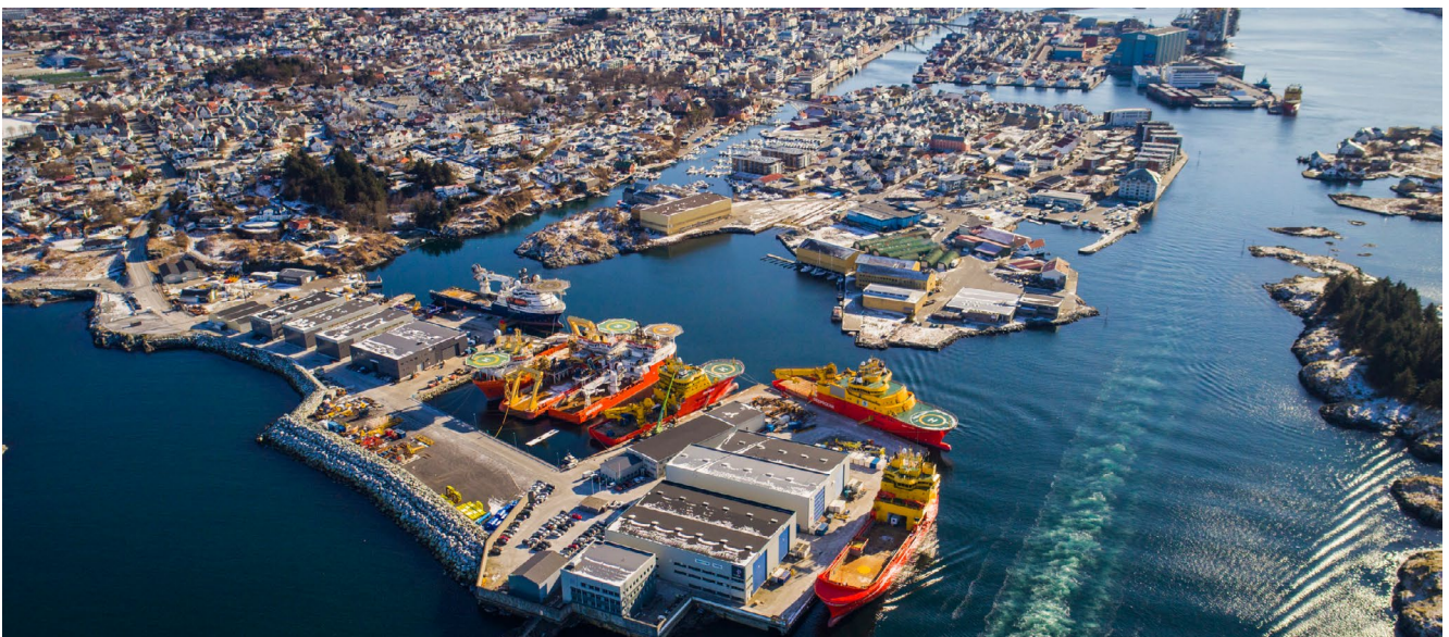
I juli 2023 overtok Havnekraft landstrømanlegget på Killingøy som kan levere en effekt på opptil 700 kW. Foto: Havnekraft
