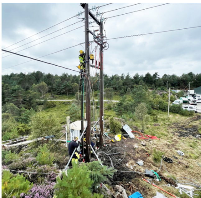
Her er nettselskapets linjemontører i aksjon med å montere nye stolper og strømlinjer i området mellom Søre Våge og Halseid.
