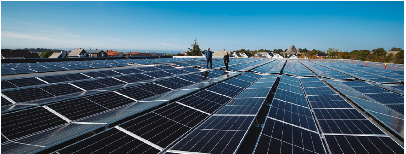
På taket av garasjeanlegget på Rossebø har Haugaland Kraft installert 938 solcellepaneler, som er et viktig bidrag til å redusere konsernets fotavtrykk. Foto: Haakon Nordvik
