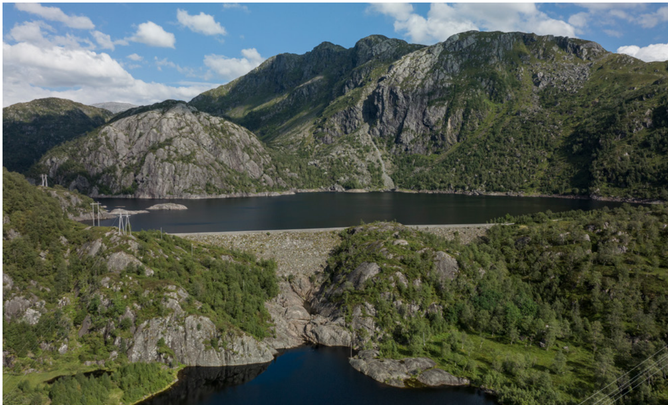
Staffivatnet i Blådalsvassdraget. Vassdraget består av totalt ti magasiner av ulike størrelse og reguleringssevne; fra Fjellhaugvatnet på 375 moh. til det øverste Blomstøsskardsvatn på ca. 1 034 moh. Fem kraftverk binder sammen vassdraget og produserer årlig 1,5 TWh. Foto: Peter Tubaas/ Vestland media
