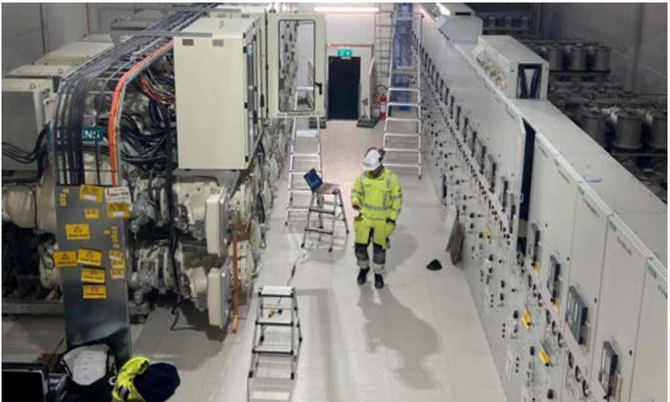
De nye høyspenningsbrytere er på plass i transformatorstasjonen på Flotmyr. Hele anlegget er kapslet og berøringssikkert.
