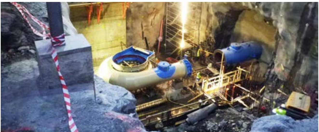
Løkjesvatn kraftverk i Etne er det største prosjektet i SKL sin omfattende utbyggingsportefølje. Den nye kraftstasjonen skal tas i bruk på slutten av 2022.
