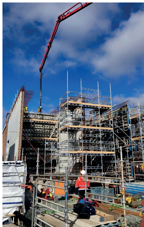
Stasjonen på Flotmyr fra 1960-tallet oppgraderes og blir nettselskapets første digitale transformatorstasjon. Det bidrar til effektivisering og økt sikkerhet.
