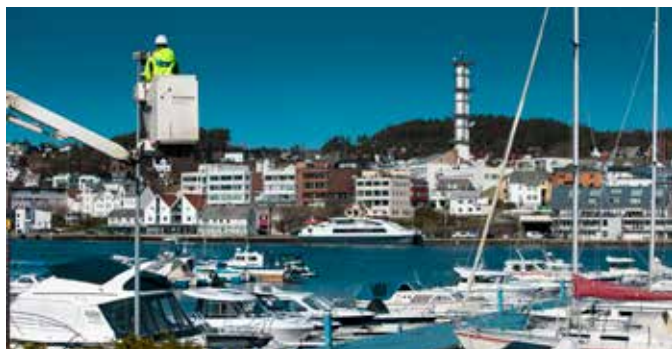
Vedlikeholdsarbeid av gatelys
