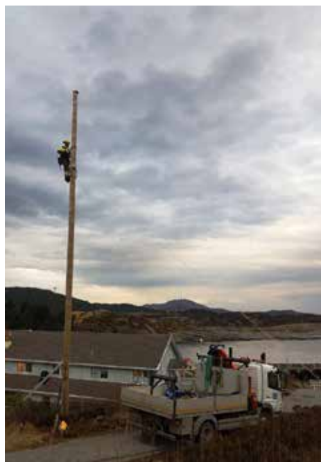
Reising av 11 m antennemast ved Arsvågen for oppdragsgiver.
