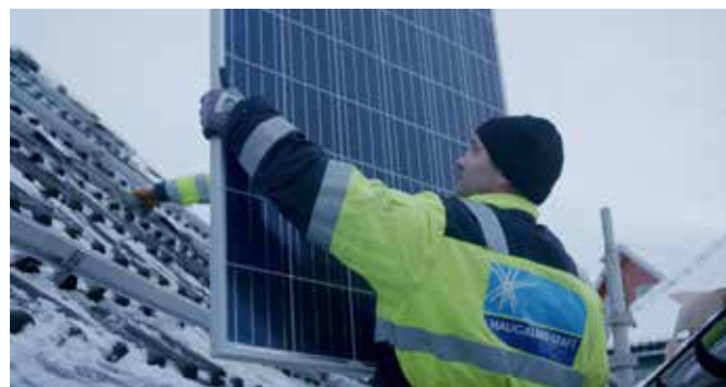
Montasje av solcelleanlegg til pilotkunder.
